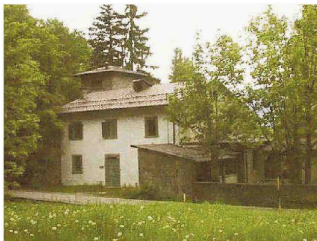
La colonia dell'Abetone dove nascerà l'accademia (foto di archivio)
